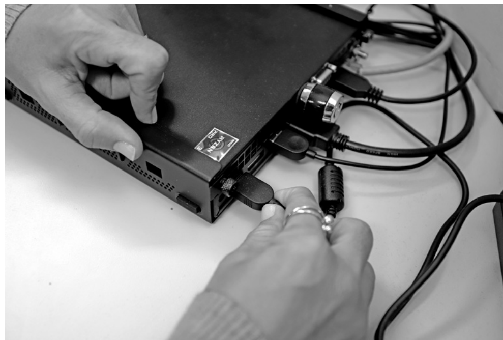
No estado, foram 35 ocorrências, entre choques, incêndios por curto-circuito e descarga de raios
